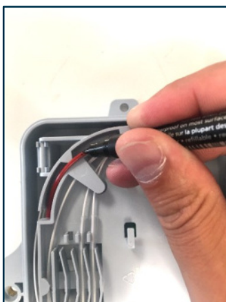
7. Marcar el tubo para su posterior pelado.
