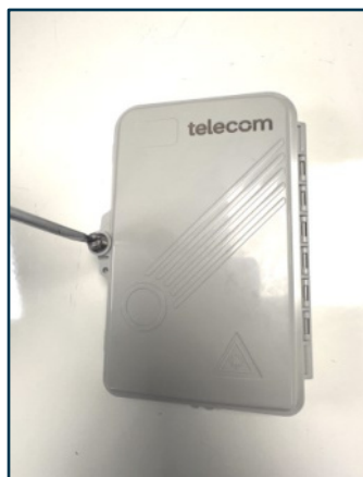
1. Abrir la tapa, para ello usar un destornillador de punta plana.
