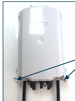
16. Cerrar la caja prestando especial atención que los broches estén correctamente cerrados.
