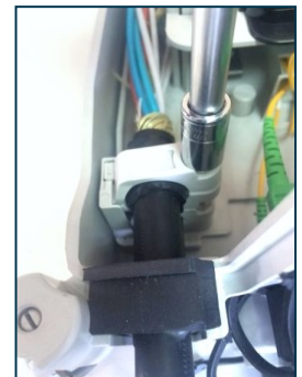
4. Fijar la brida de retención, para ello usar una llave de vaso del nº8.
