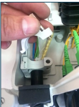
1. Retirar la brida de retención de cubierta superior.
