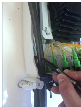
2. Introducir el cable en punta a través del obturador de goma, marcar el cable para su pelado.
