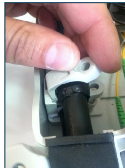
3. Una vez pelado y engrosado posicionar la brida de retención sobre el cable.
